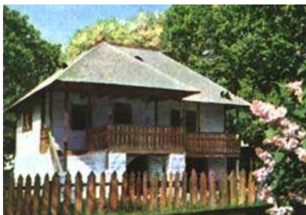
Foto nr.4: Casa su due piani (zona Buzau)
